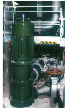
Rückwärtslaufende Kreiselpumpe „Hallschlag“ wieder Anfragen, was zeigt, daß das Thema weiter köchelt.“ Anfragen kommen noch aus anderen Bereichen, und zwar für die Gaswäsche und die Seewasserentsalzung.
